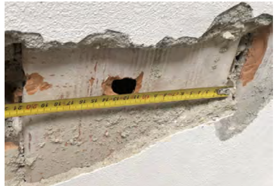
Rilievo dimensionale del laterizio forato
