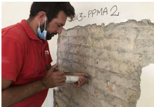
Esecuzione prova ed attrezzatura utilizzata
