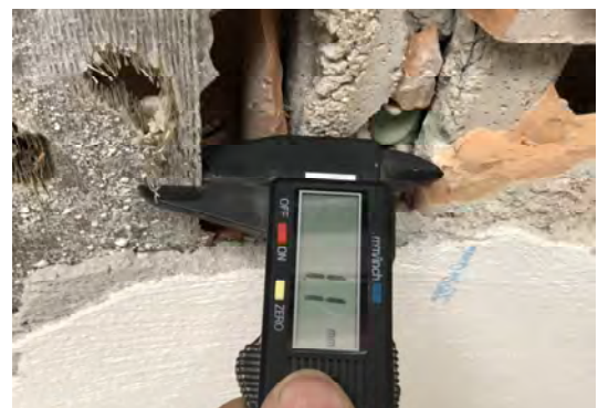
Fascia metallica, posta alla base del laterizio forato di 100mm di larghezza ed 1mm di spessore
