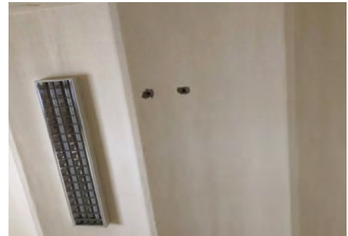
Intradosso solaio a voltine di mattoni
