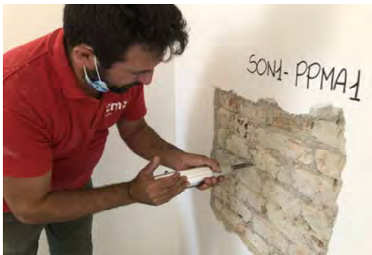
Esecuzione prova ed attrezzatura utilizzata
