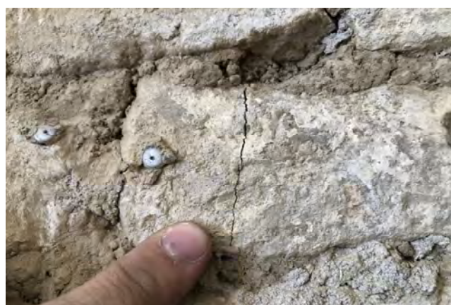
Lesioni di elementi alla pressione massima raggiunta.
