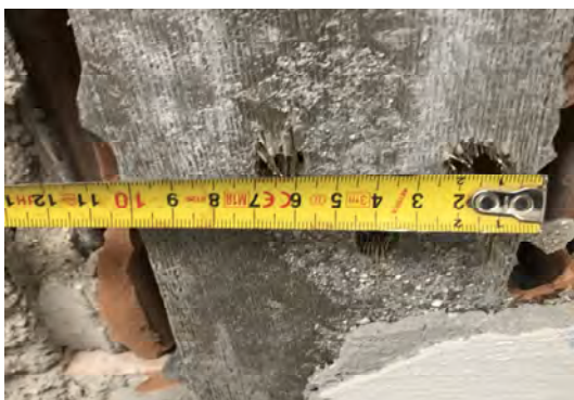
Fascia metallica, posta alla base del laterizio forato di 100mm di larghezza ed 1mm di spessore
