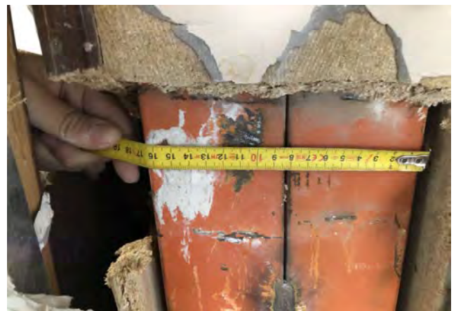
Rilievo dimensionale dei profilati metallici e particolare della saldatua
