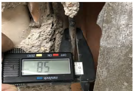
Armatura del travetto - \phi 6 liscio
