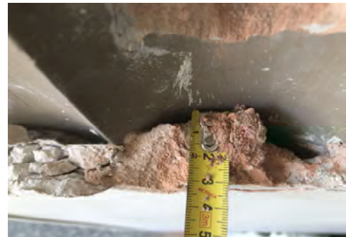
Spessore intonaco e rivestimento in cls
