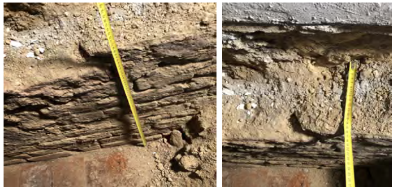
Rilievo ringrosso parete perimetrale
