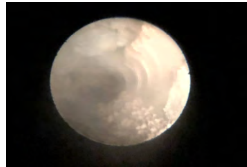
Foto frontale a cm 15 - Mattone pieno e corso di malta verticale
