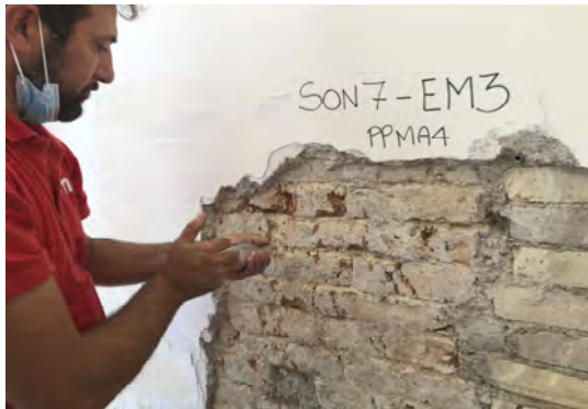
Esecuzione prova ed attrezzatura utilizzata
