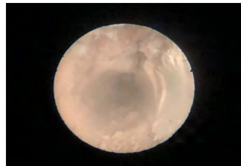
Foto frontale a cm 59 - Mattone pieno e corso di malta verticale
