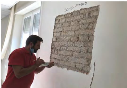
Esecuzione prova ed attrezzatura utilizzata
