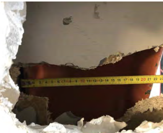
Rilievo dimensionale dei profilati metallici e particolare della saldatua
