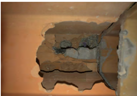
Laterizio forato e intradosso della soletta di cls armata
