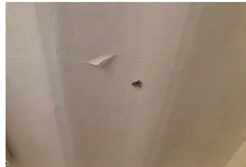
Intradosso solaio a voltine di mattoni
