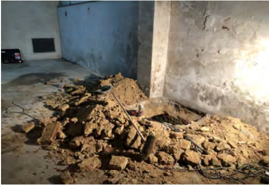
Ubicazione saggio in fondazione
