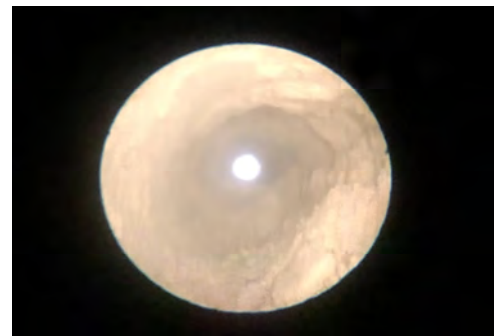
Foto frontale a cm 30 - Mattone pieno e corso di malta verticale
